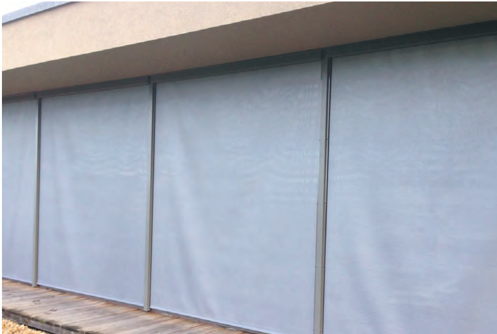
Bild 9.4.6 V-förmige Wellen
